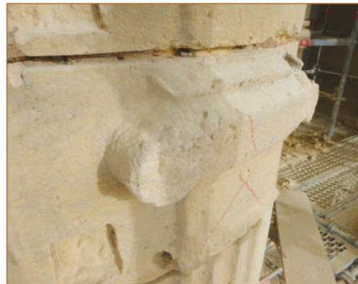
Chapiteau sur pile cannelée
