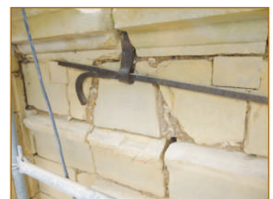
la lézarde avec mise en place de témoins ; ces derniers n'ont pas bougé lors des travaux
