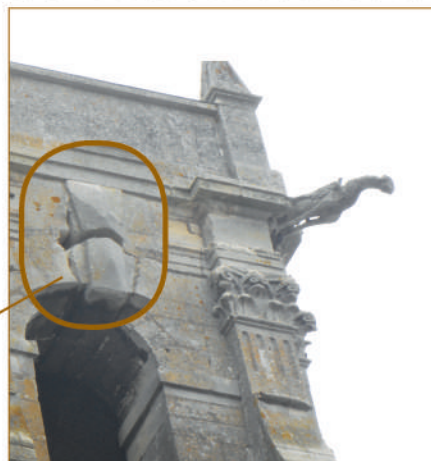
Zoom sur l'affaissement de la clé de voûte
