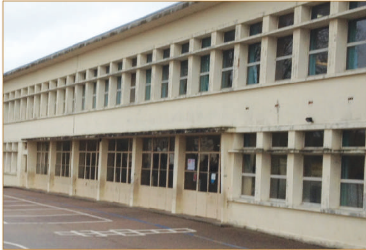
La rénovation du groupe scolaire Coty, priorité du mandat.
