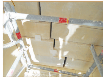
la lézarde avec mise en place de témoins ; ces derniers n'ont pas bougé lors des travaux
