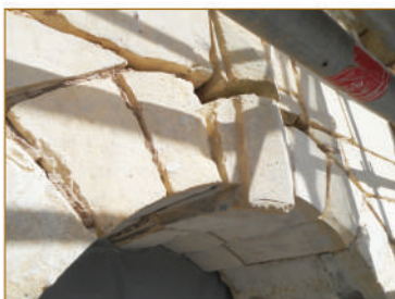
Zoom sur l'affaissement de la clé de voûte
