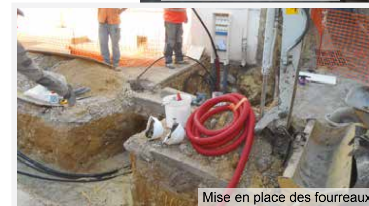
Mise en place des fourreaux
