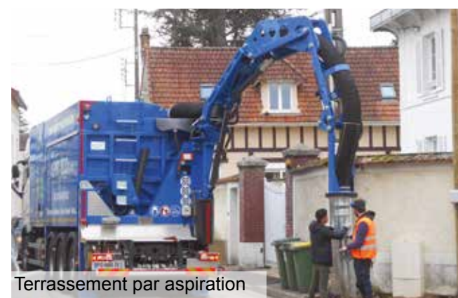
Mise en place des fourreaux
